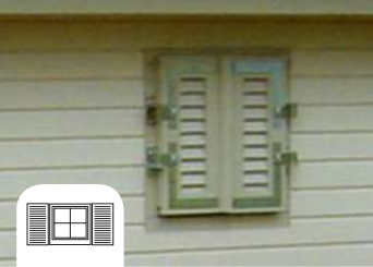
Fenster mit o. ohne Klappläden
