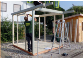
Aufbau der Skelettstruktur
