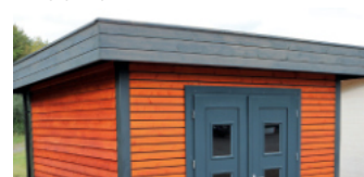
Flachdach (mit Dachüberstand)
