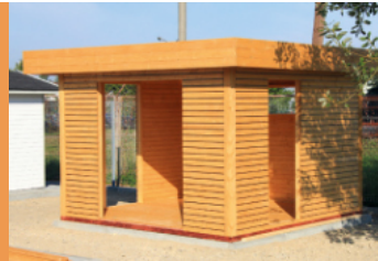
Dach- und Wandschalung
